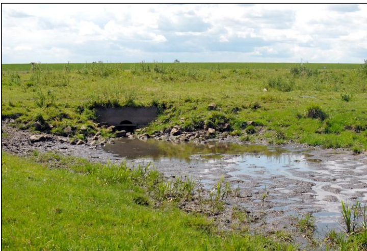
Der südl. Durchlass – DN 500 von der Gebietsseite
