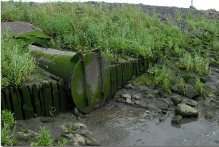
Der nördl. Durchlass – DN 1000 von der Weserseite
